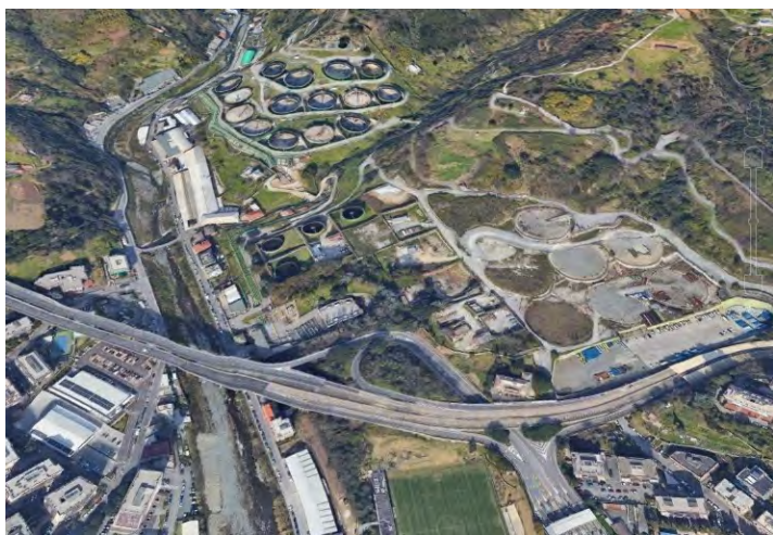
I grandi serbatoi di idrocarburi allo sbocco a Pegli della Val Varenna, subito a monte dell'autostrada A10, bel contrasto rispetto alla fotografia precedente. (immagine da Google Earth, situazione IV/2022)
